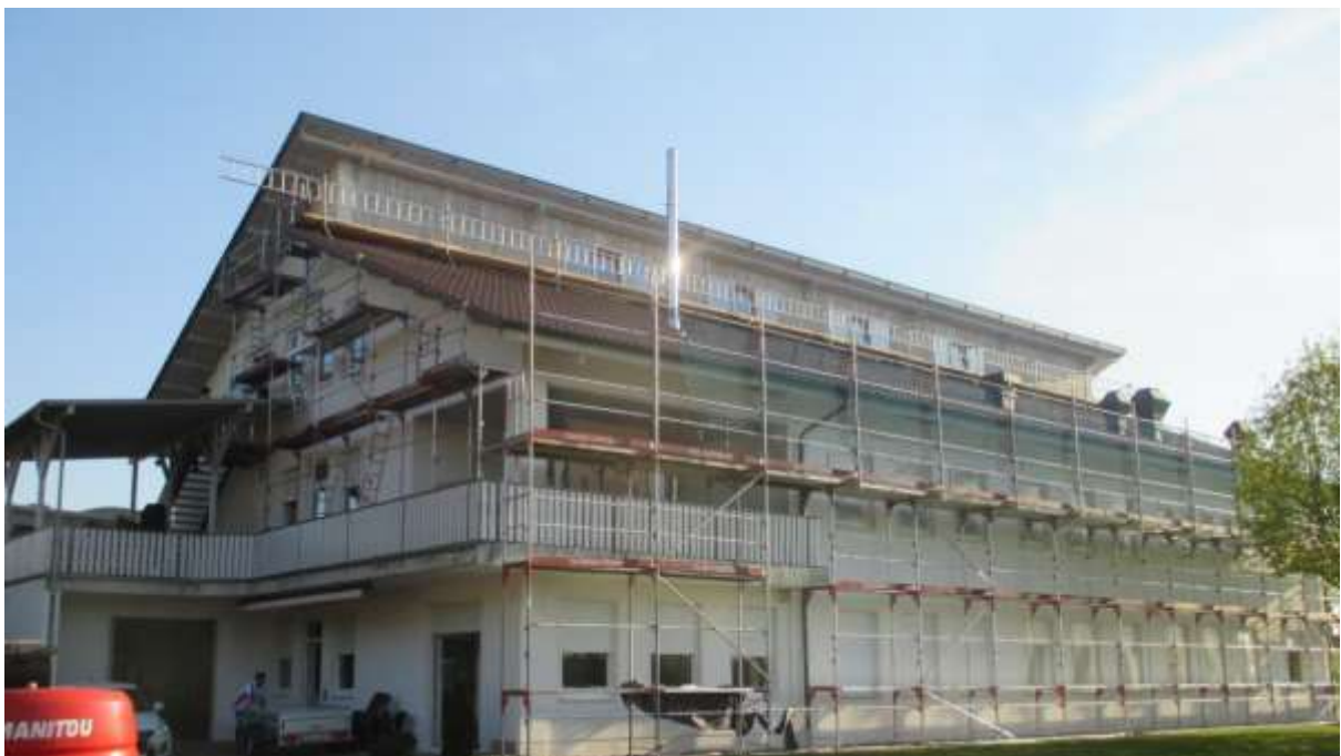
Sanierung der Fassade 2018
